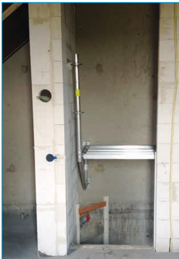
Trapgatconsole in gesloten trapgat
