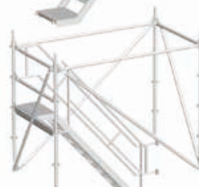
Tour d'escalier intermédiaire
